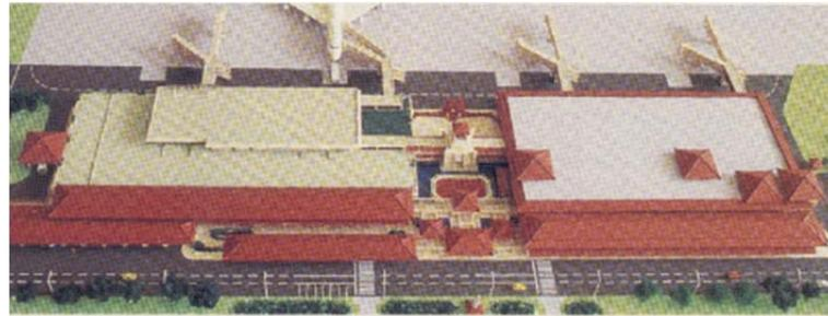
**Maket Terminal Penumpang Rute Internasional (sisi kiri sudah ada, sisi kanan dibangun baru)**
